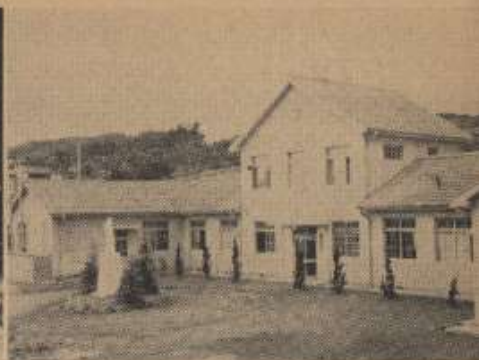
みさかえの園の建物
